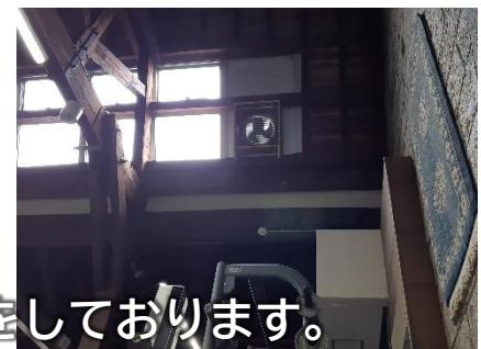
通路に設置した給気口より外気を取り入れ、各エリア換気扇にて排気をしております。
