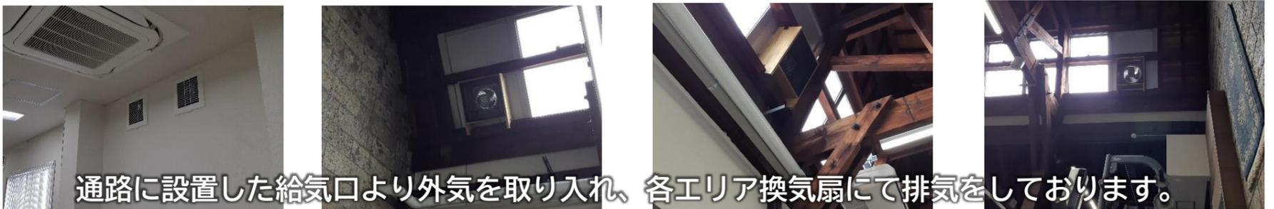
通路に設置した給気口より外気を取り入れ、各エリア換気扇にて排気をしております。
